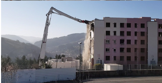
Démolition Quartier La Plata / Tarare / 2019
